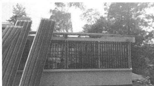
Foto1: .Desinstalación de lámina existente en un aula
