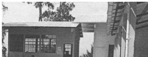
Foto 4: Instalación de capote para lámina troquelada
