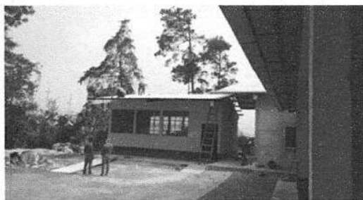
Foto 3: Suministro e intalación de láminas troqueladas
