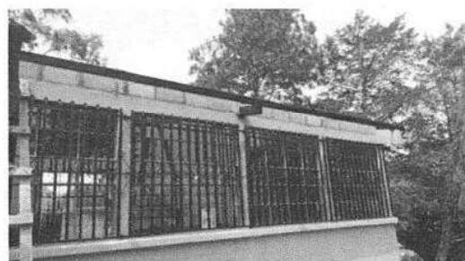
Foto 2: Remoción de óxido y aplicación de anticorrosivo en costaneras
